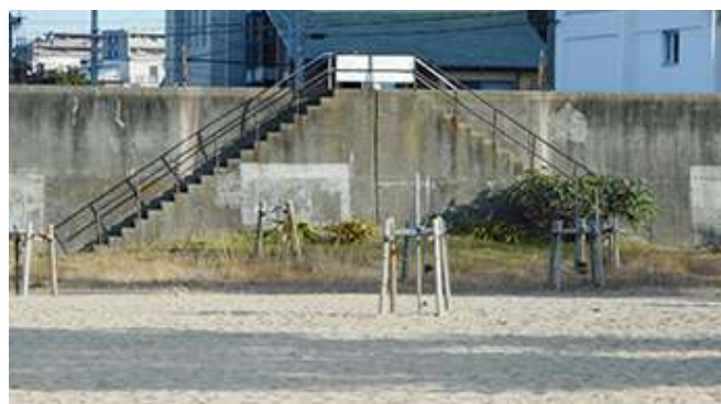
北側の出入口（壁北側は建石線）
